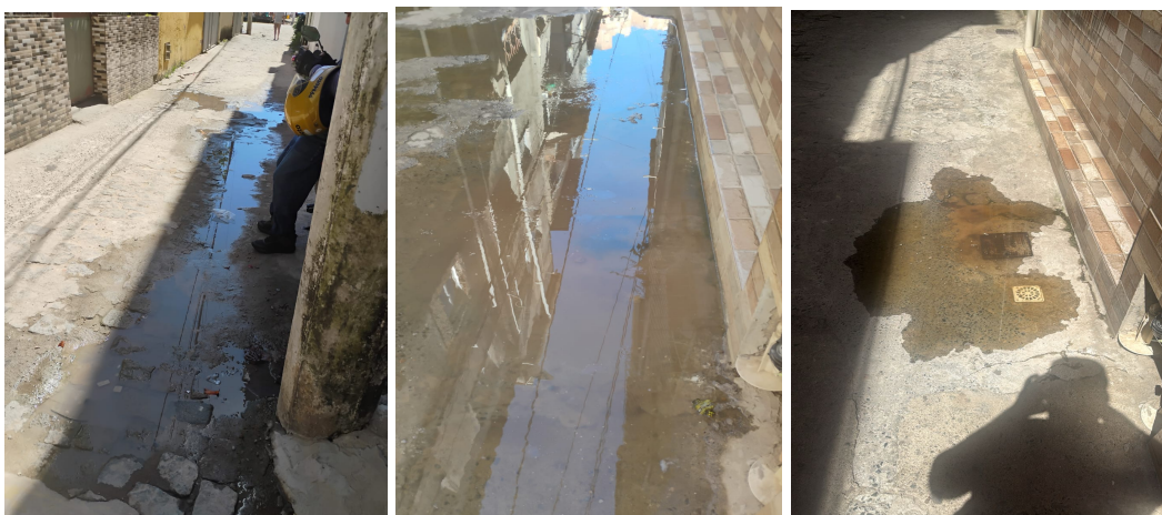
Fotos do esgoto vazando na da Rua Grajaú em frente a casa de número 06 no bairro Itapuã.
