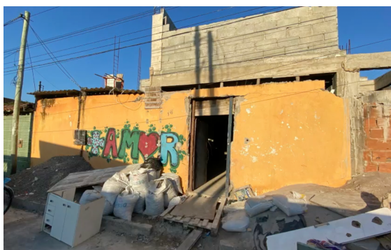
Antes — obras e entulhos
