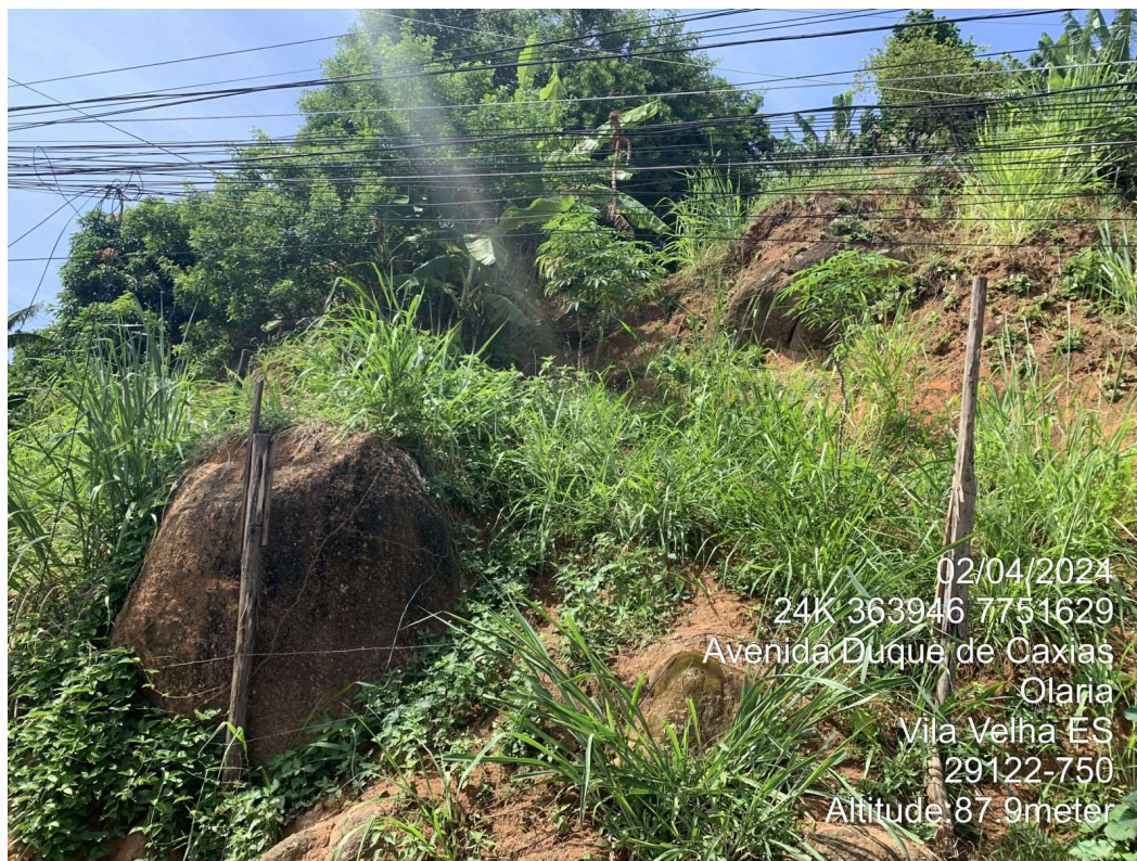
Foto 03 – Panorama à montante do bloco mais visível e próximo da via.
