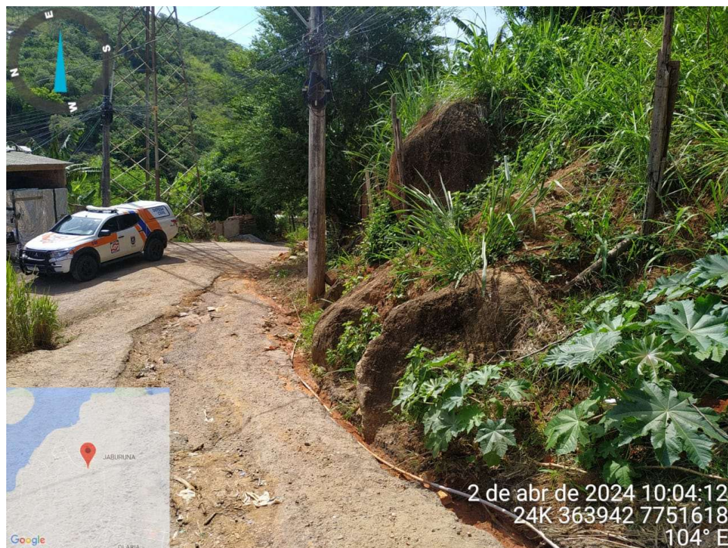
Foto 04 – Via de acesso próxima ao local.
